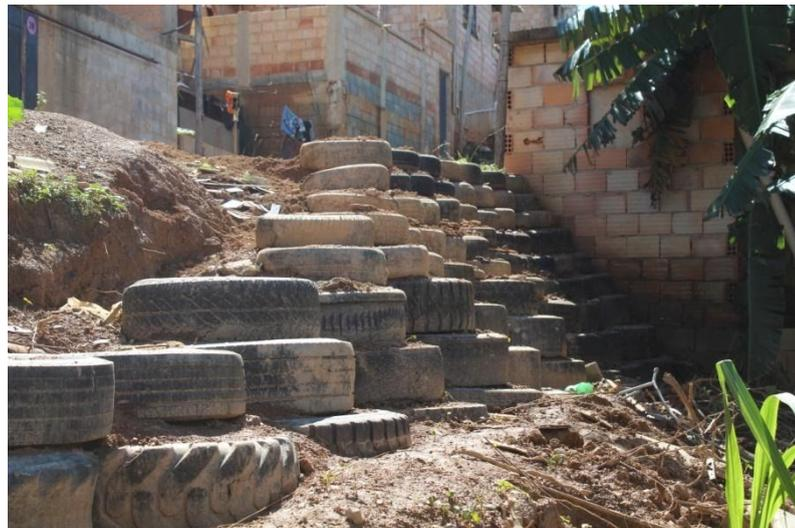
**Figura 5:** Contenção construída com pneus
