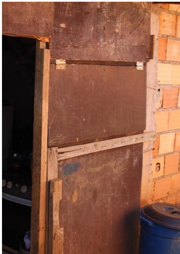
**Figura 3:** Vedação de Guarda-Roupa desmontado
