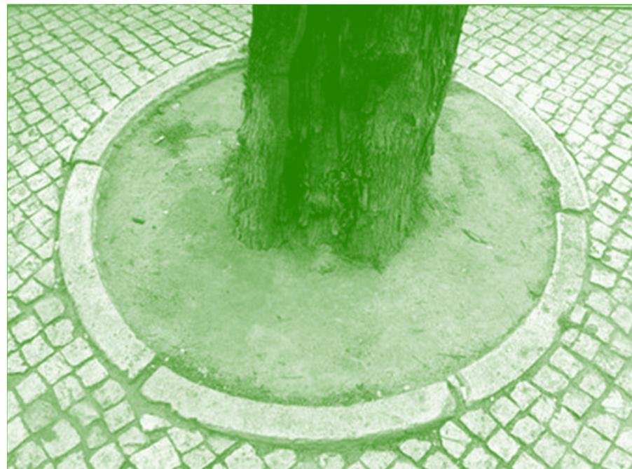
● canteiro de uma árvore deve ser espaçoso para permitir a infiltração da água e nutrientes. Na imagem, além deste ser mínimo, foi cimentado, perdendo completamente ● seu objetivo.
